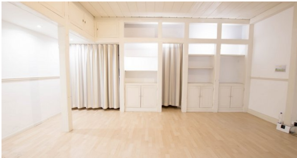
Raum mit Einbauten
